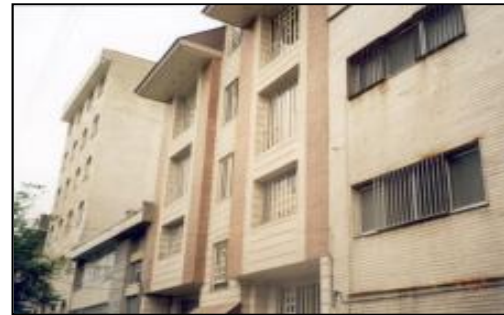
اجرای کلیه کارهای ساختمانی/ساختمان کردستان/تهران/ایران
