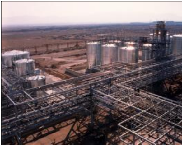
لوله کشی پایپ رک
